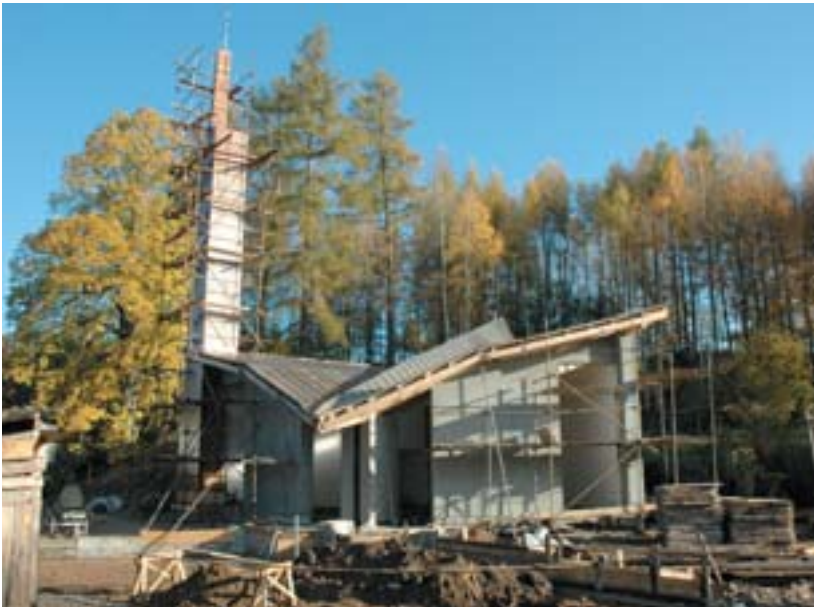
Před dokončením hrubé stavby
