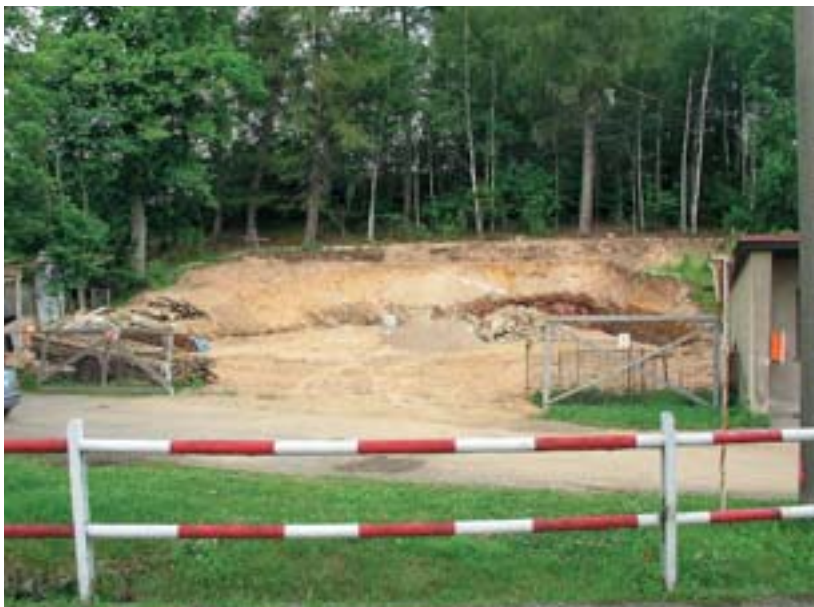
Úprava terénu před stavbou kostela
