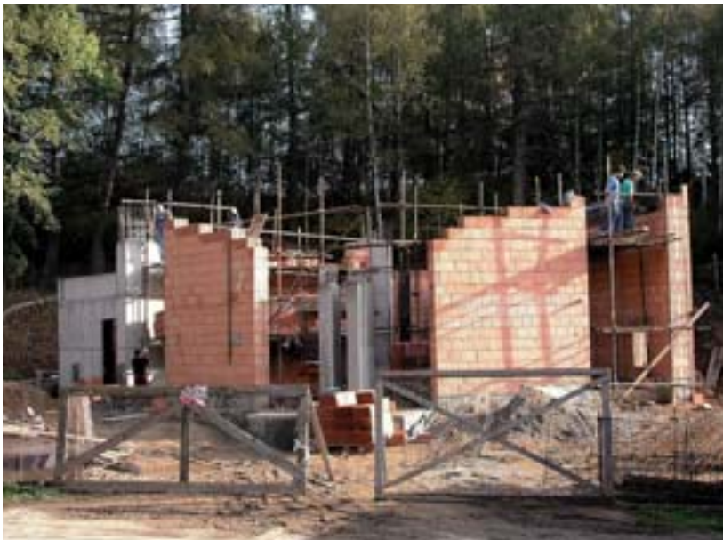
Stavba nosných zdí a betonáž základů kostela
