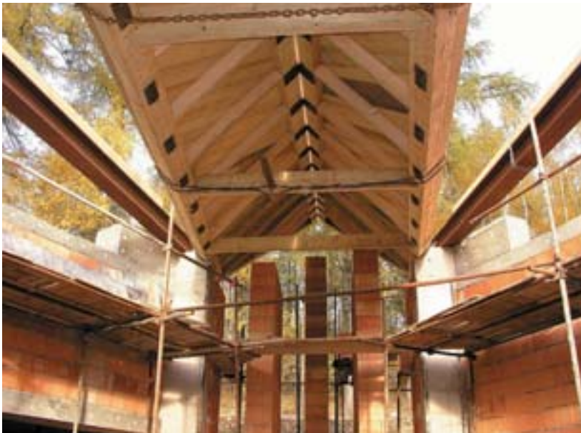
Usazení krovu na hrubou stavbu
