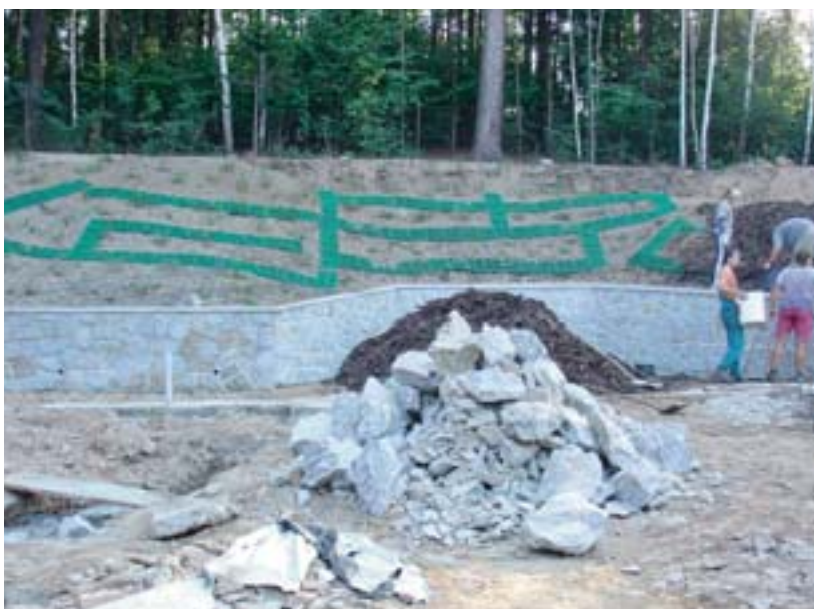
Dohotovění kamenného soklu opěrné zdi a zpevnění svahu
