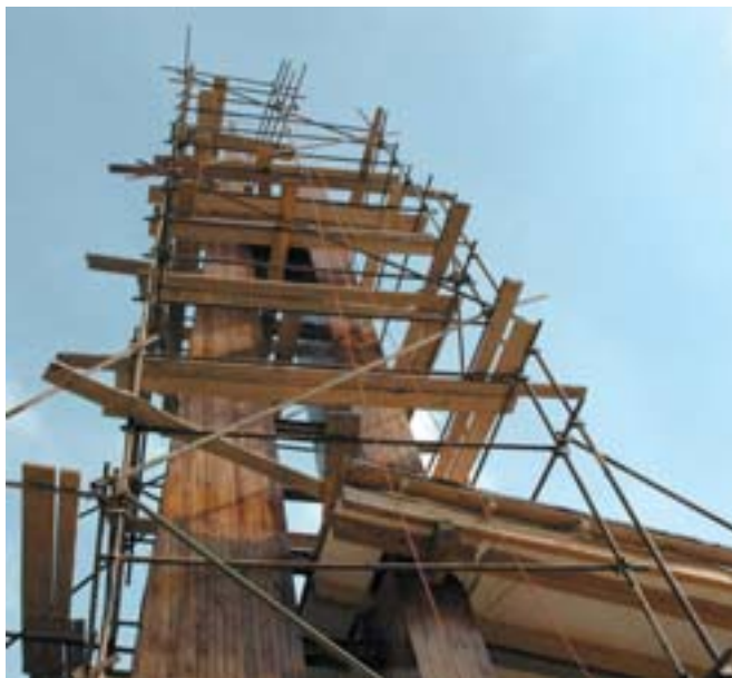
Bednění a montáž konstrukce věže
