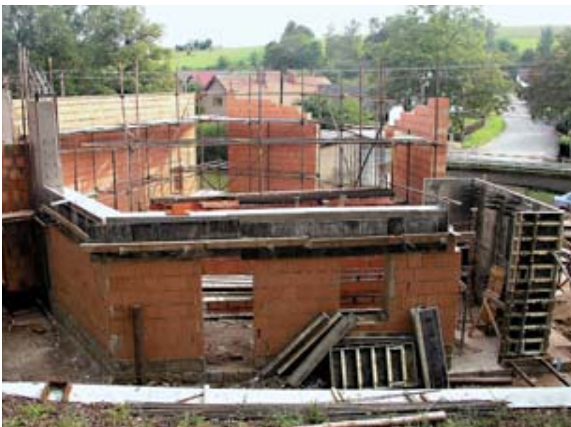
Dokončování nosných zdí a pilířů
