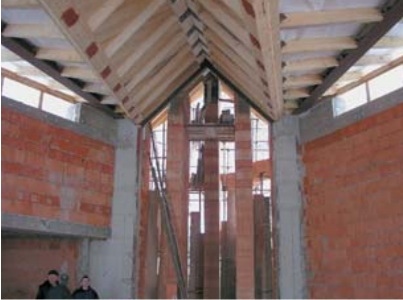
Interiér kostela v průběhu hrubé stavby
