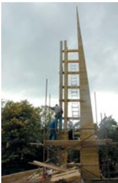
Bednění a montáž konstrukce věže
