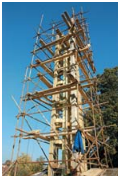
Bednění a montáž konstrukce věže
