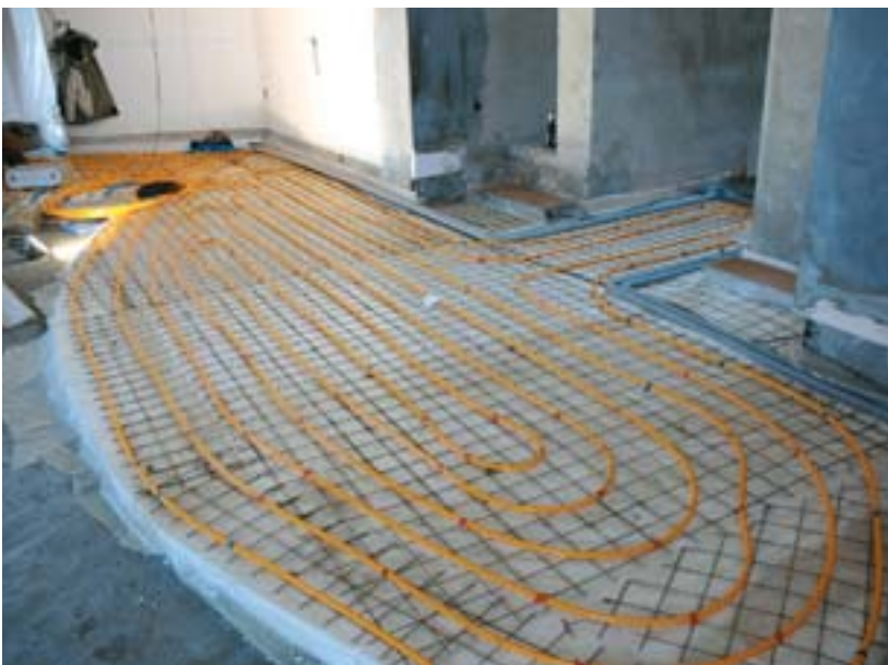
Pokládání podlahového topení
